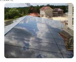
Мини-метеостанция, встроенная в систему обогреваемых кровель из стекла, также позволяет использовать экономный энергорежим, автоматически включая обогрев стеклопакетов по показаниям температуры воздуха в диапазоне от -30 до +5 градусов Цельсия и наличия осадков. Настройки позволяют запрограммировать индивидуальный подогрев отдельных стеклопакетов — при образовании на них наледи.
