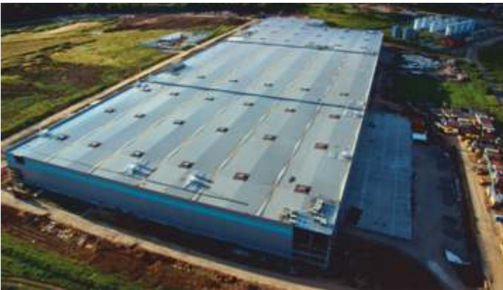
▲ Белый Раст Логистика . - Гидроизоляция кровли с использованием мембраны Rhenofol CV фирмы FDT корпуса А складского комплекса «Белый Раст Логистика», 12.2011-05.2012 гг., 70000 м 2
