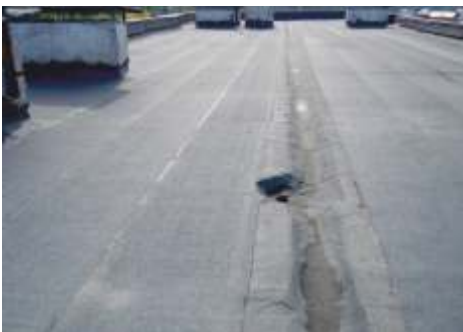
▲ База отдыха «Оз. Круглое». Устройство кровли гостиничного центра, 2011 г., 1200 м 2
