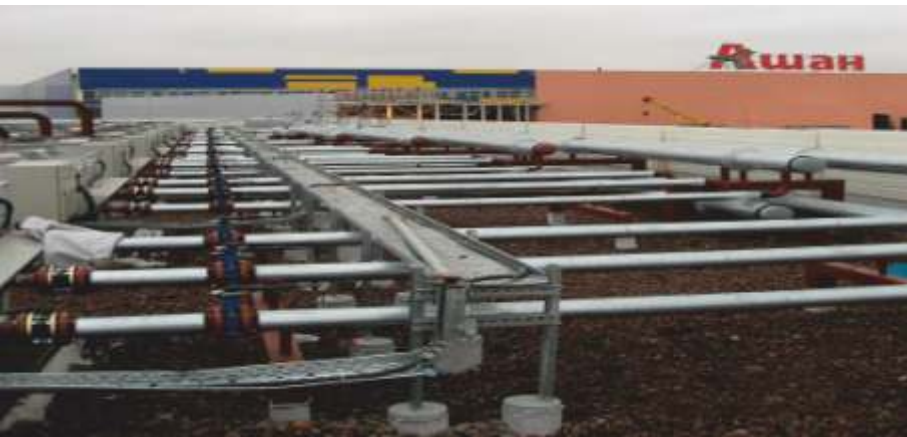
◀ Тех. здание Мега – Белая Дача. Гидроизоляция кровли с использованием мембраны SGmA фирмы Sika технического здания ТЦ Мега-Белая Дача, 08.2006-10.2006 гг., 2000 м 2
