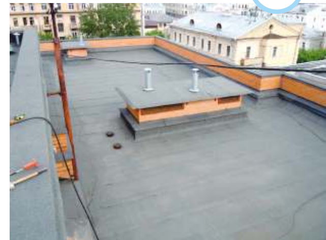
▲ Устройство кровли жилого здания на Б.Сухаревском переулке , 2012г., 1200м 2
