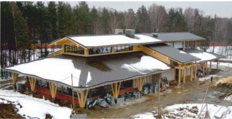
▲ Устройство металлической фальцевой кровли зданий частного загородного комплекса в Балашихе, 5200 м 2
