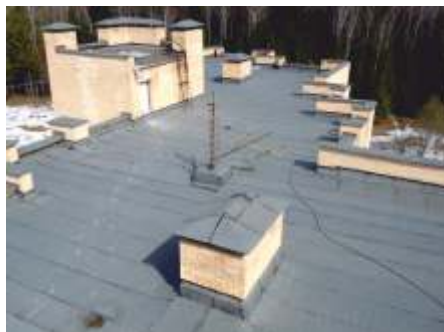
▲ База отдыха «Оз. Круглое». Устройство кровли гостиничного центра, 2011 г., 1400 м 2
