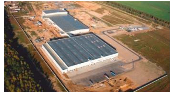
Ферреро. Гидроизоляция кровли с использованием мембраны Rhepanol fk фирмы FDT завода «ФЕРРЕРО», 12.2008-08.2009 гг., 70000 м 2
