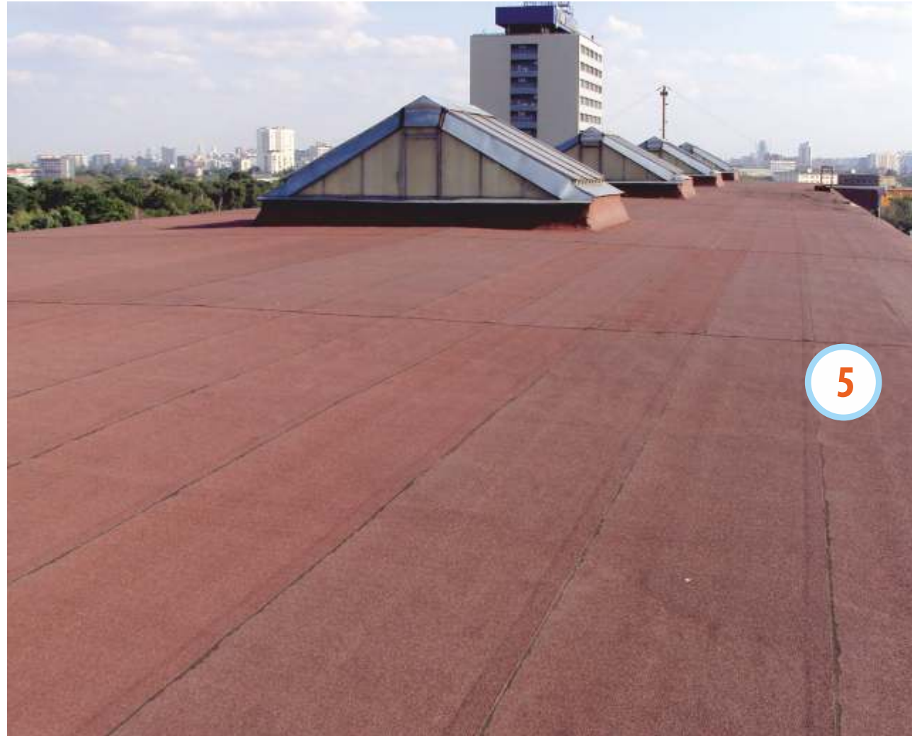
▲ ФГУП «ТТЦ«Останкино». гидроизоляция кровли Аппаратно-Студийного Комплекса -3, 2006 г., 1600 м 2
