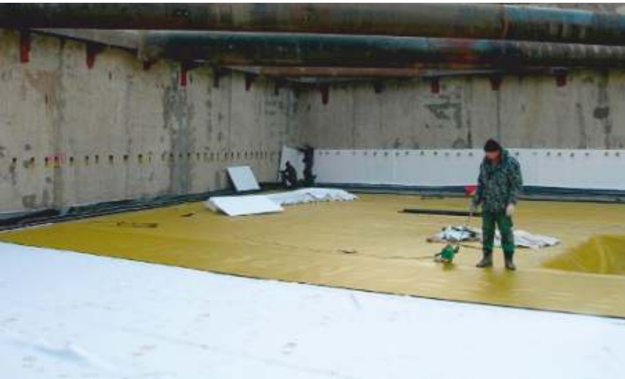
▲ Озерковская набережная. Гидроизоляция фундамента с использованием мембраны Sikarplan 9,6 фирмы Sika делового центра по Озерковской набережной, 11.2005-05.2006 гг., 6000 м 2
