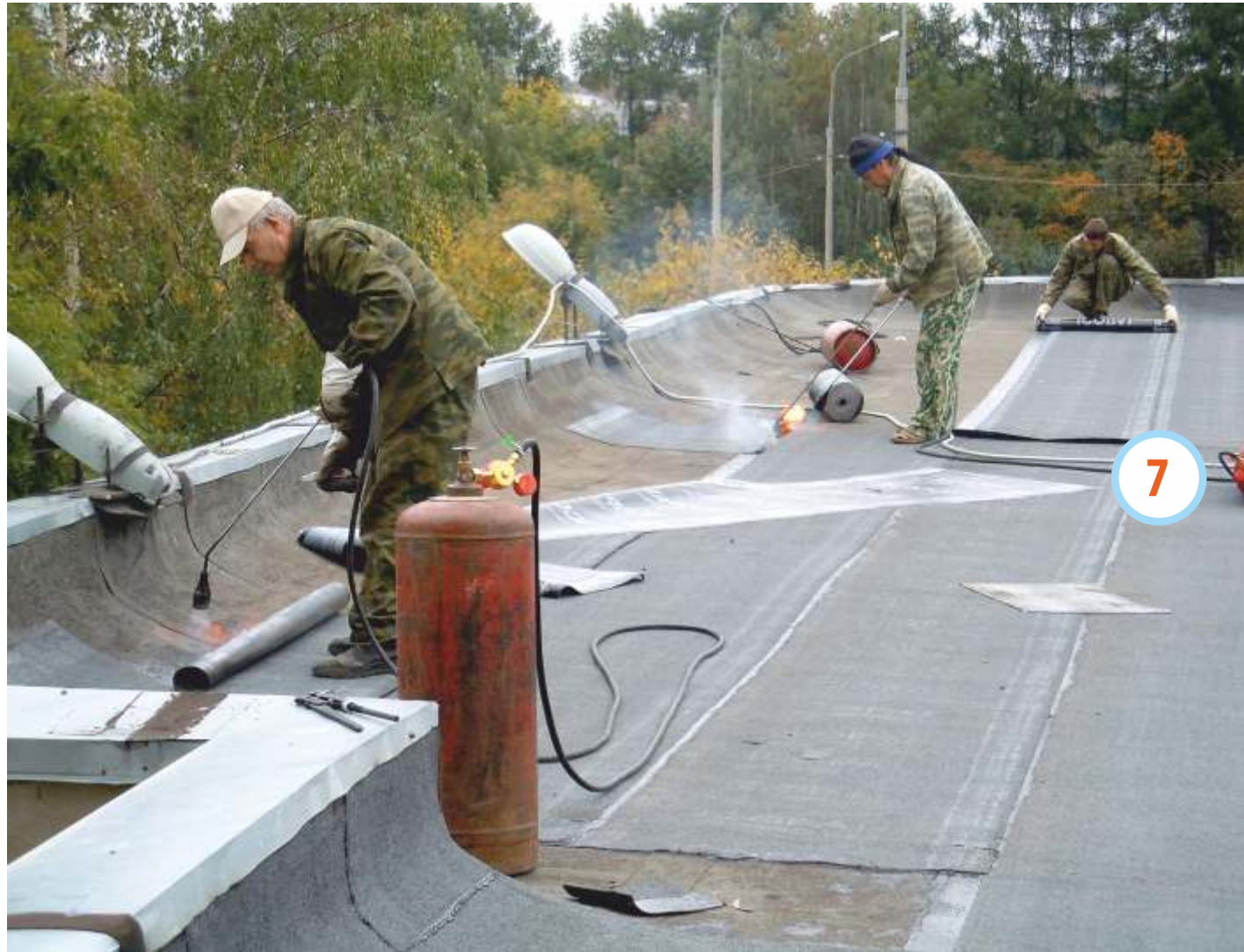
▲ Устройство кровли здания административно-офисного центра Уайтхол-Центр на Дмитровском шоссе, 1150 м 2
