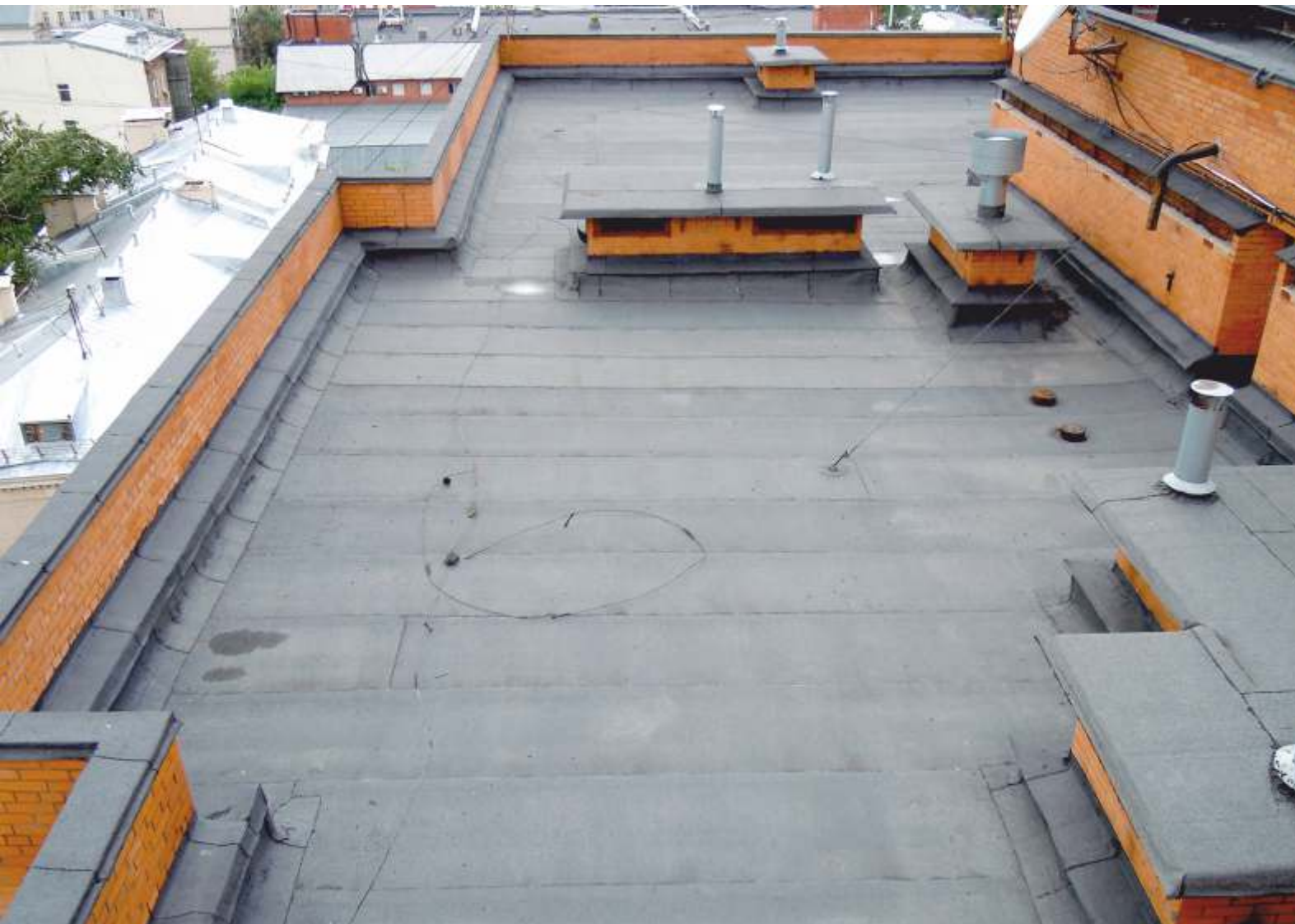
▲ Устройство кровли жилого многоквартирного здания на Б.Сухаревском переулке , 2012г., 1200 м 2
