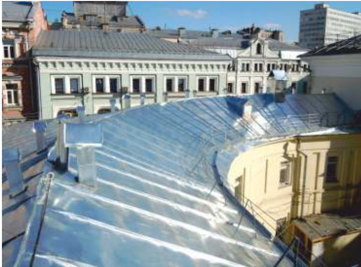
▲ Технический надзор, подготовка технического отчета по устройству металлической кровли административного здания «РосПотребНадзор»
