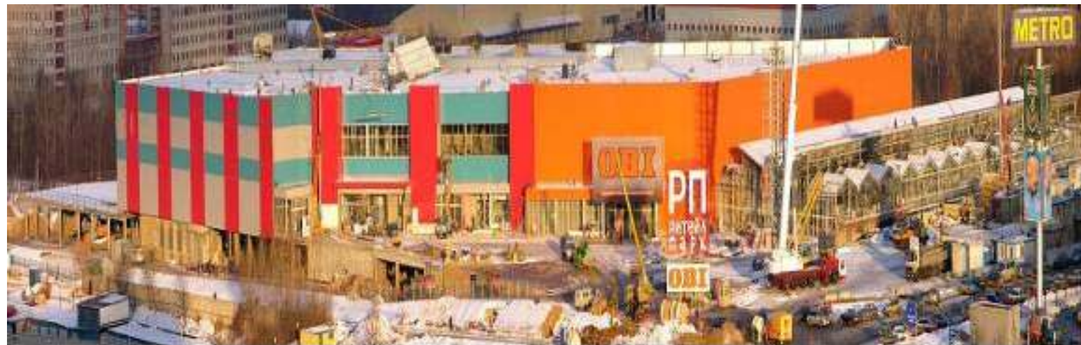
▶ Ритейл-Парк. Гидроизоляция кровли с использованием мембраны 200D фирмы Van Besouw ТЦ «РитейлПарк» 09.2005-11.2005 гг., 15000 м 2
