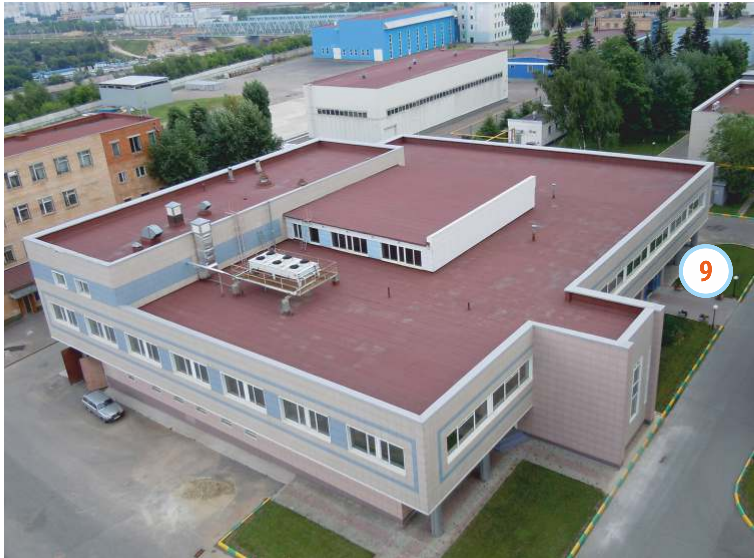
▲ ОАО «Московский Завод Полиметаллов» . Гидроизоляция кровли корпуса столовой, 2010 г., 2200 м 2
