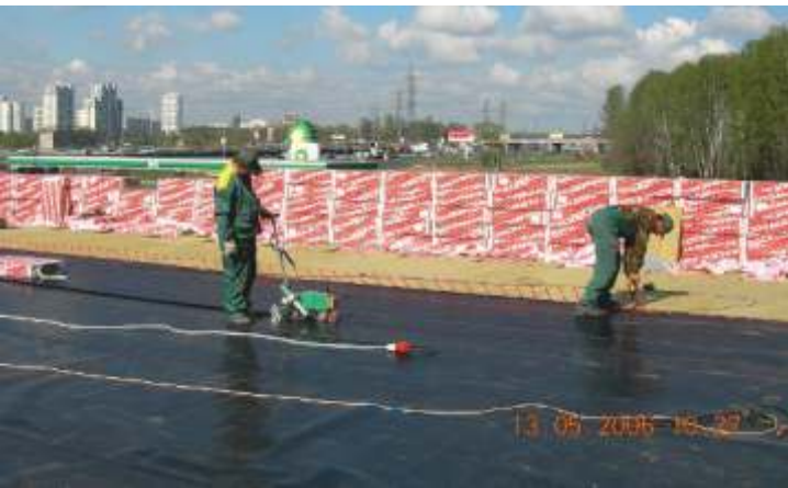
▲ СТО Форд . Гидроизоляция кровли с использованием мембраны Carisma фирмы Sika СТО Форд на 85 км МКАД, 05.2006-07.2006 гг., 4000 м 2
