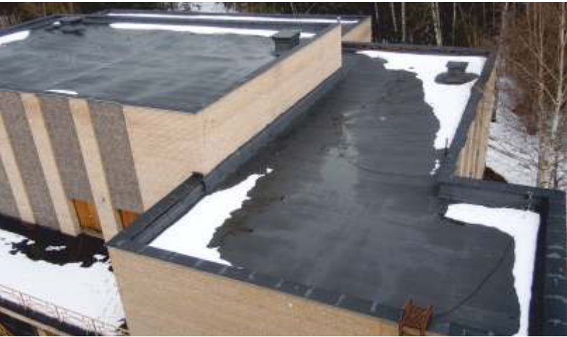
▲ База отдыха «Оз. Круглое». Устройство кровли физкультурно-оздоровительного комплекса, 2010г., 2400 м 2
