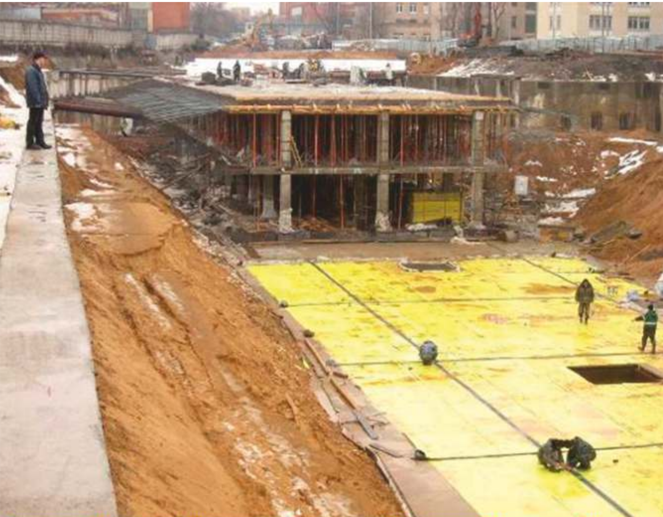
Гараж ГKB им. Боткина. Гидроизоляция подземного гаража ГKB им Боткина с использованием мембраны Sikaplan 9,6 фирмы Sika 09.2006-06.2007 гг., 25000 м 2
