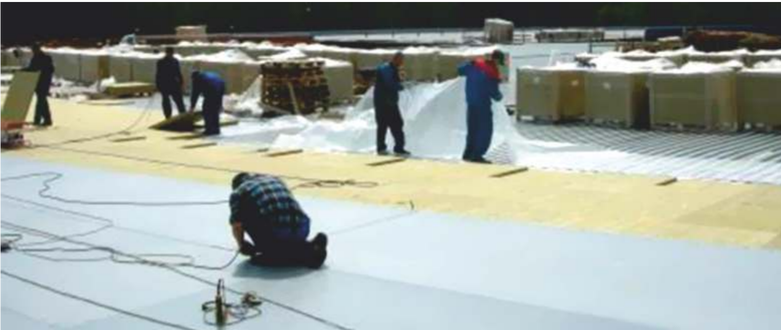
◀ Шерленд. Гидроизоляция кровли с использованием мембраны 200D фирмы Van Besouw 2-й очереди складского терминала «Шерленд», 06.2008-04.2009 гг., 30000 м 2
