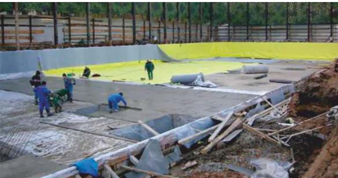
▲ Московский Картонажный Комбинат. Гидроизоляция фундамента комплекса зданий Московского Картонажного Комбината с использованием мембраны Sikaplan 9,6 фирмы Sika , 09.2007- 10.2007 гг., 15000 м 2
