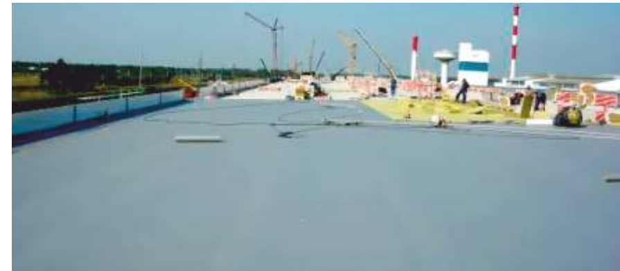
Главербель-Клин. Гидроизоляция кровли с использованием мембраны ALKOPLAN 35276 фирмы RENOLIT AG завода «Главербель-Клин», 08.2008- 12.2008 гг., 15000 м 2
