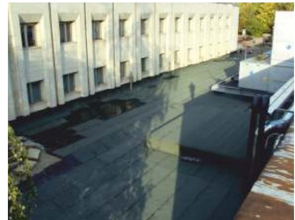
▲ ФГУП «ТТЦ «Останкино». Гидроизоляция кровли подземной части Холодцентра, 2011 г., 1800 м 2
