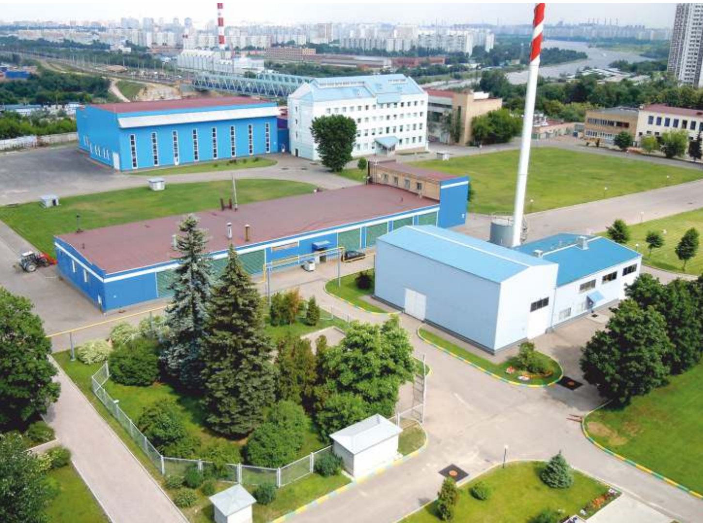
▲ ОАО «Московский Завод Полиметаллов». Гидроизоляция кровли комплекса зданий с 2005 по 2012гг, площадью ок. 27 000 м 2
