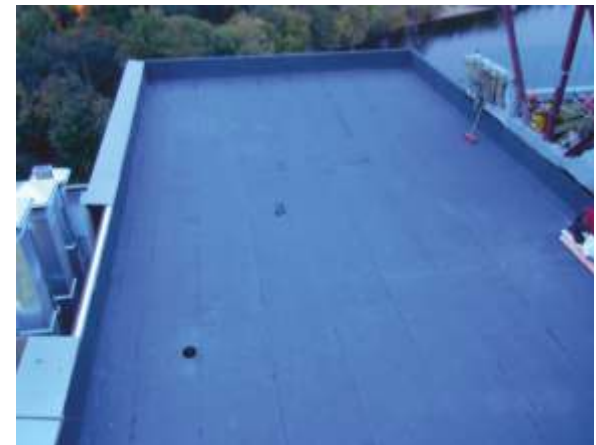
▲ «Город Яхт». Устройство совмещенного кровельного покрытия жилого многоквартирного комплекса, 2012 г., 450 м 2
