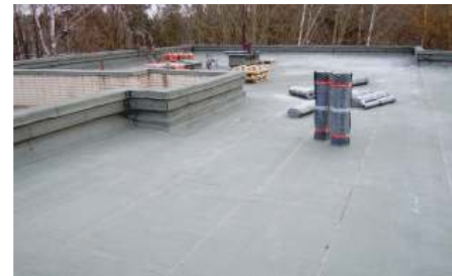
▲ База отдыха «Оз. Круглое». Устройство кровли гостиничного центра, 2011 г., 600 м 2
