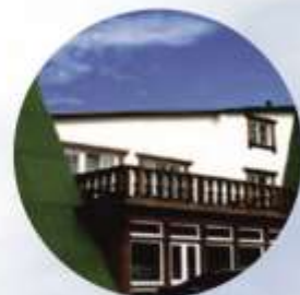
ПРИДОРОЖНЫЙ КОМПЛЕКС ООО "ВИКОН"
