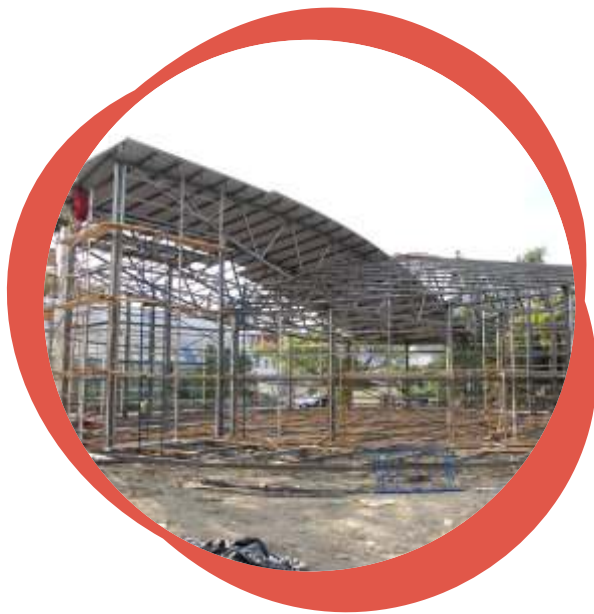
в процессе строительства
